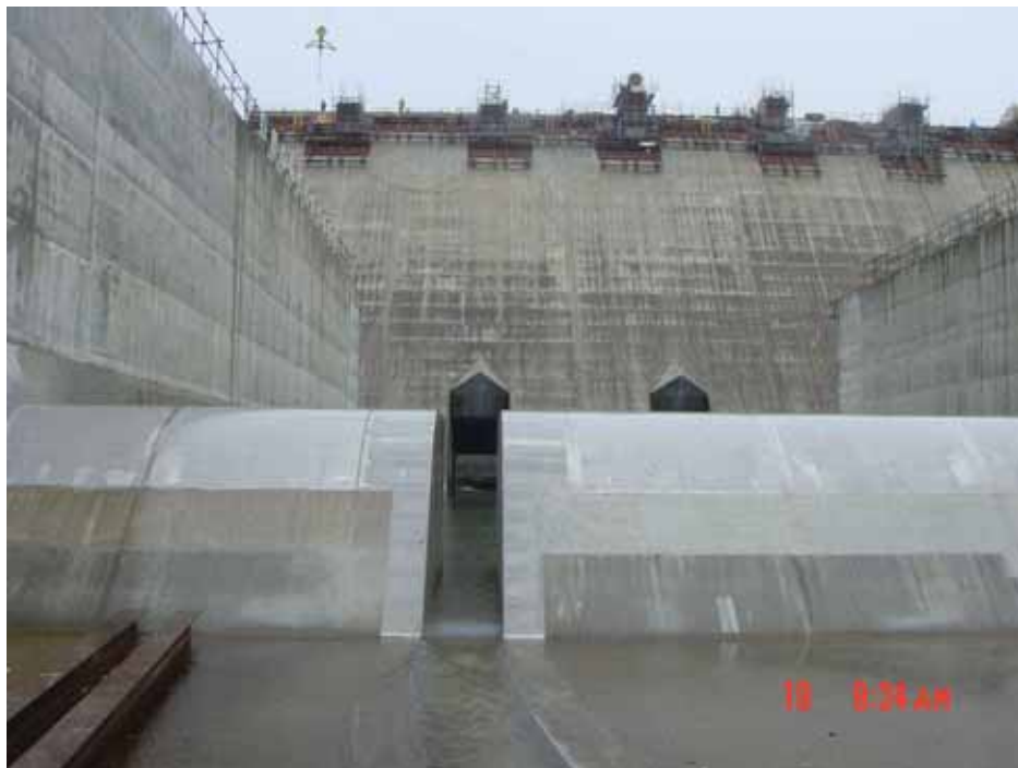
減勢工および副ダムスリット
