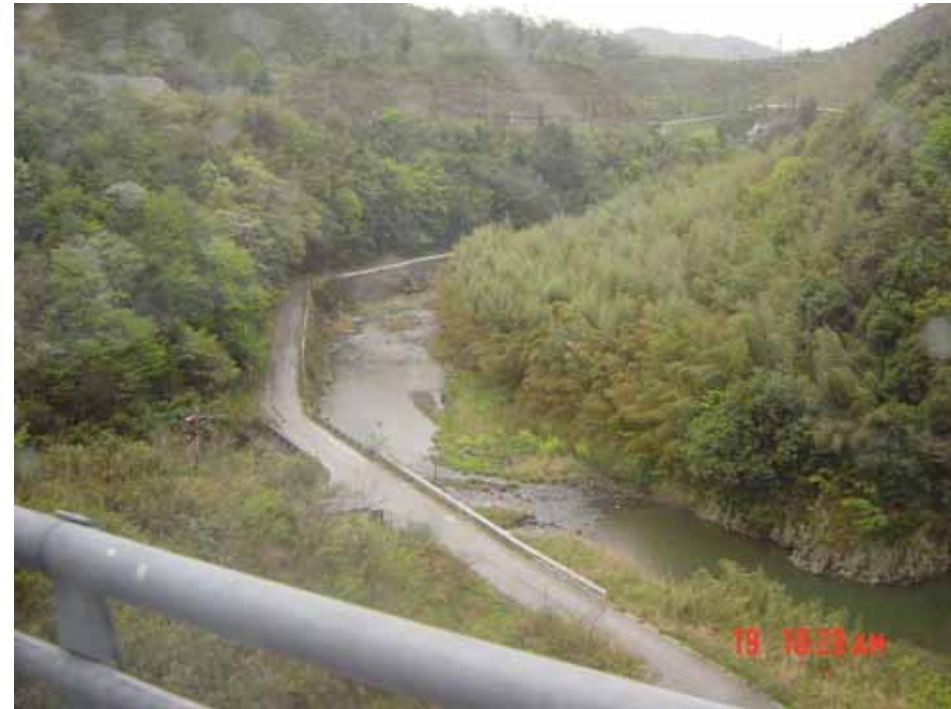
貯水池内の状況(現況河道)
