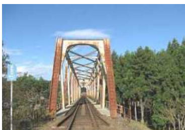
第2世代橋梁(建設S53年)
