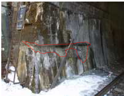
トンネル（コンクリート剥離）
