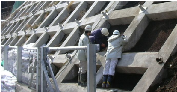
県営建設工事完成検査状況
