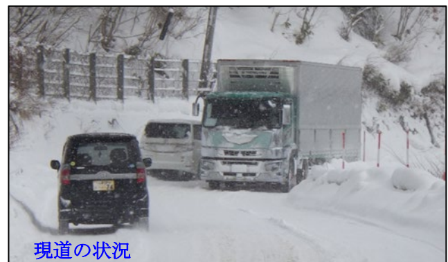
(主) 二戸五日市線 柿ノ木平工区 (二戸市) ※R3~12 予定
