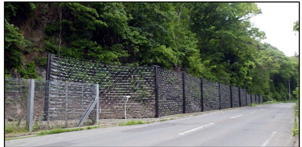
(一)二戸一戸線 小間木地区(二戸市) ※R4 完了
