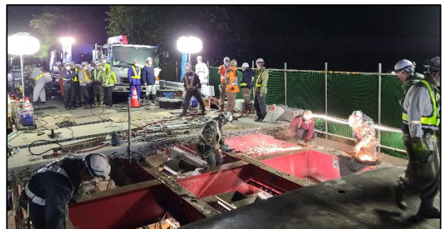
(国)395号 猿越橋(軽米町) ※R4 完了
