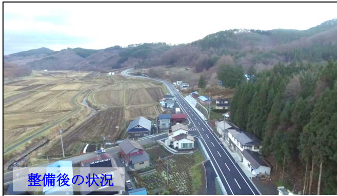
(一) 一戸浄法寺線 中里工区 (一戸町) ※R3 完了
