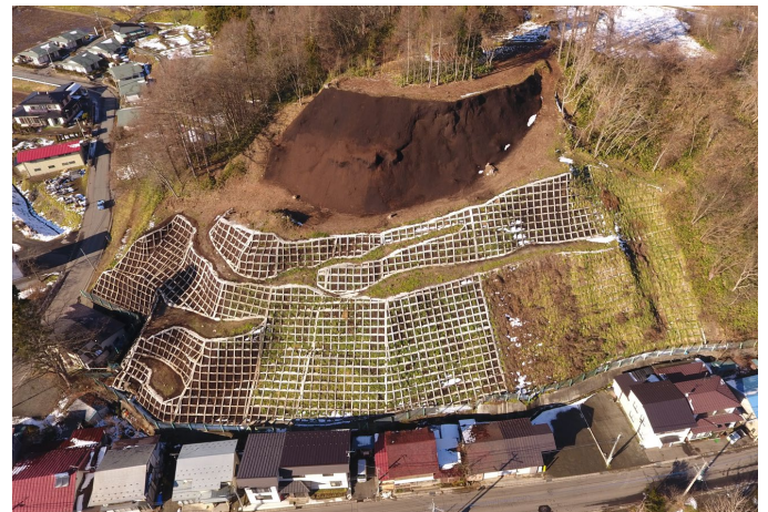
急傾斜地崩壊対策事業(二戸市八幡館地区) ※R3 完了
