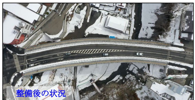
(都) 荒瀬上田面線 岩谷橋工区 (二戸市) ※H22~R6 予定
