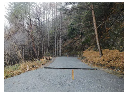
森林作業道整備（釜石市、整備後）
