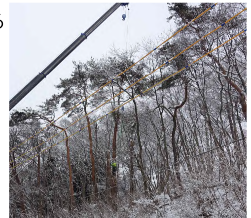
松くい虫被害を受けた枯死木の除去 （令和6年遠野市）
